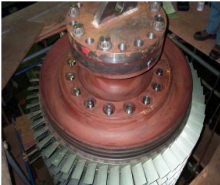
รูปที่ 21 แสดง การวาง Compressor Rotor ของ MS9161E ลงบน Vertical Stand ที่อยู่ระดับเดียวกับพื้น Workshop และตั้งนั้งร้านขึ้นไปรับ เตรียมการถอดแยก
