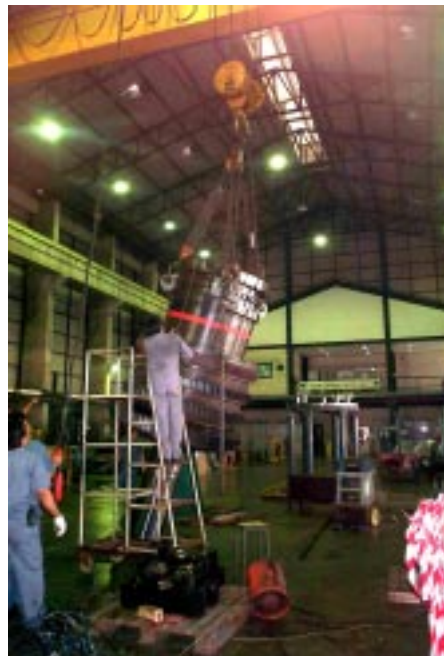
รูปที่ 19 แสดง วิธีการ Turn Turbine Rotor to Vertical ของ MW701D
