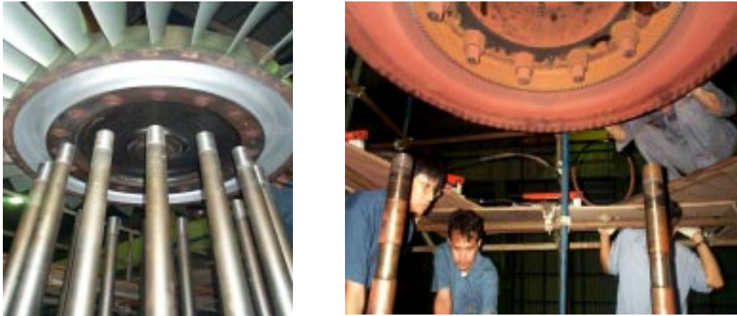
รูปที่ 25 แสดงการยก Disc และ Rotor Component อื่นๆออก เพื่อเตรียมการ Inspect
