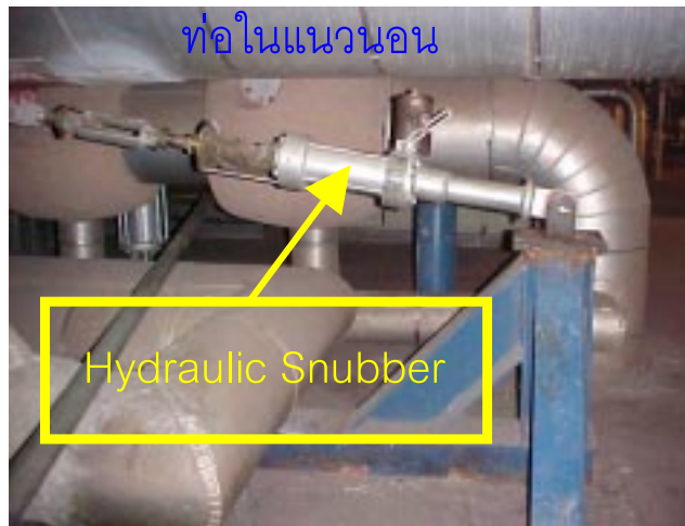
รูปที่ 8 แสดงให้เห็นลักษณะการติดตั้ง Hydraulic Snubber เพื่อหน่วงการเคลื่อนที่อย่างกะทันหันของท่อ
