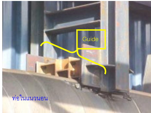
รูปที่ 6 แสดงท่อในแนวนอนที่ถูก บังคับให้เคลื่อนที่ได้เฉพาะ ในแนวยาวของท่อ
